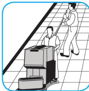
Restriegue el piso con una almohadilla roja o su equivalente. Pase el trapeador por las zonas excesivamente mojadas que haya dejado la máquina. No enjuague el piso después del mantenimiento. Deje que el piso se seque por completo.
